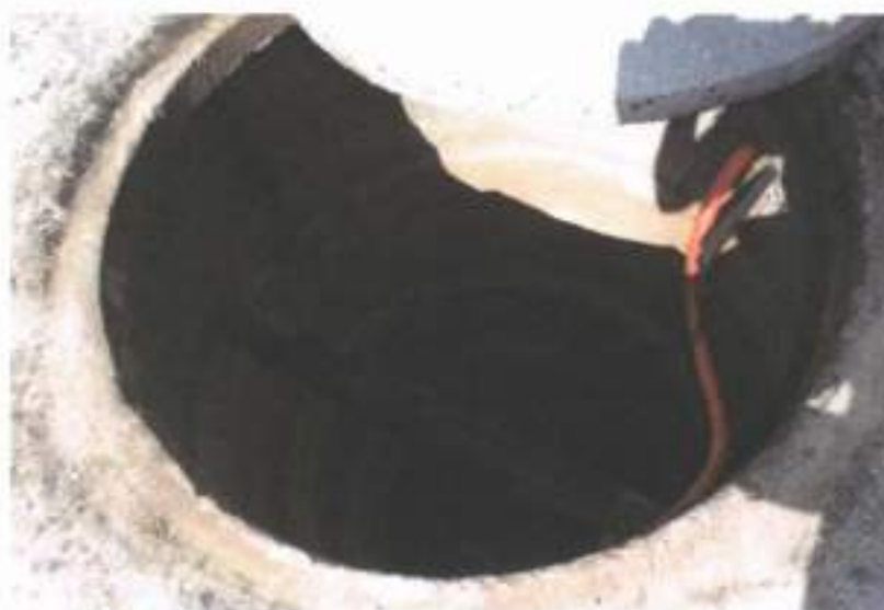
Figura 21 - Captação subterrânea para abastecimento de água na área rural do município de Pedra Bela.
