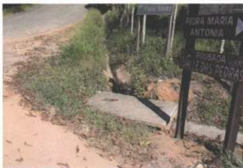
Figura 34 - Sistema de valeta para escoamento superficial de águas pluviais na área rural.
