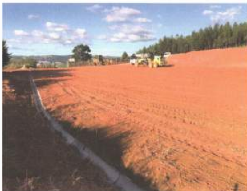
Figura 32 - Aterramento dos RSD em Valas no Município de Pedra Bela.
