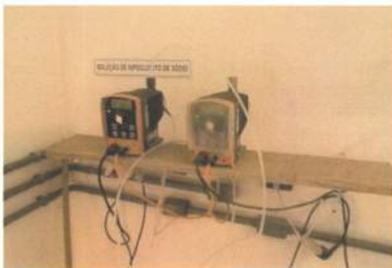
Figura 18 - Sistema de adição de hipoclorito de sódio.
