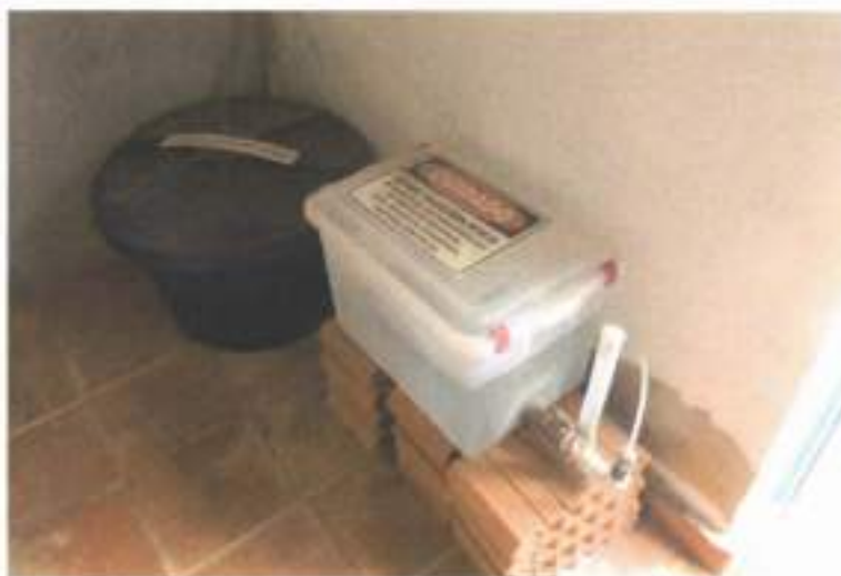
Figura 19 - Sistema de adição de ácido fluossilícico.
