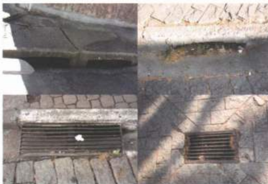
Figura 33 - Sistema de Boca de Lobo no Município de Pedra Bela.
