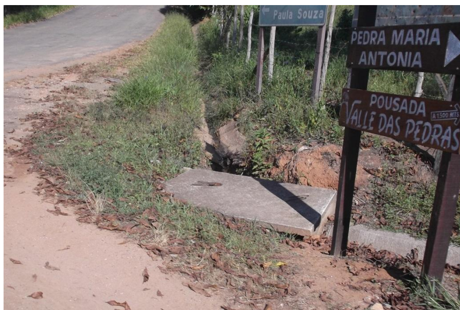
Figura 34 - Sistema de valeta para escoamento superficial de águas pluviais na área rural.
