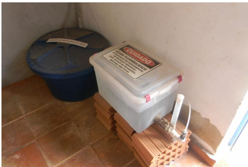
Figura 19 - Sistema de adição de ácido fluorsilícico.
