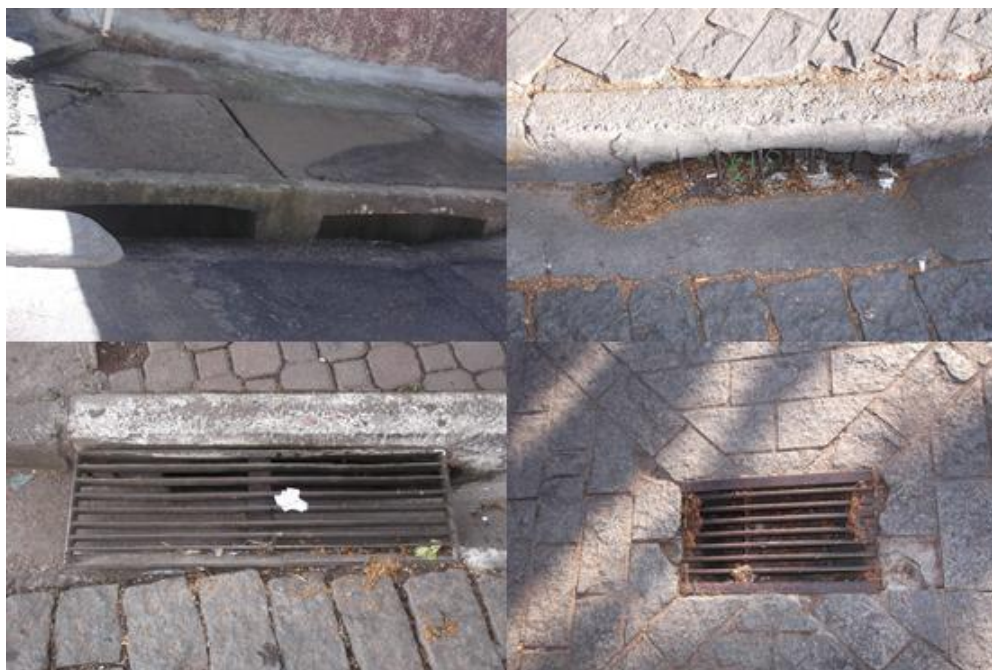
Figura 33 - Sistema de Boca de Lobo no Município de Pedra Bela.
