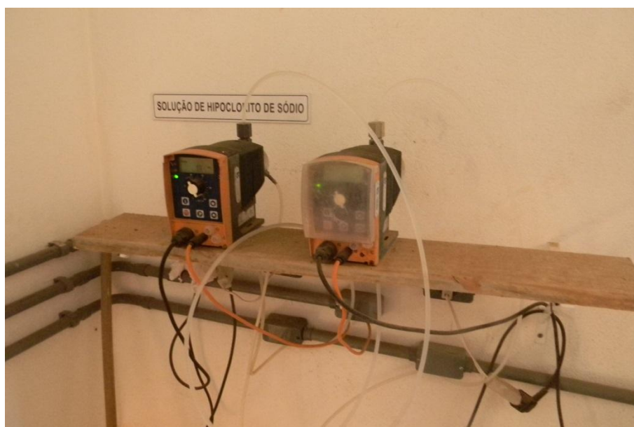
Figura 18 - Sistema de adição de hipoclorito de sódio.
